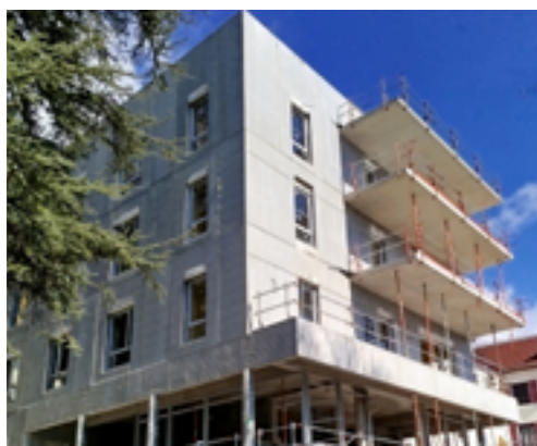
En chantier • EHPAD Saint-Germain à La Tronche (48)
