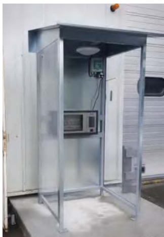
ecos key 20 et 40 en utilisation extérieure sur différents sites militaires, chacune étant équipée d'un toit pour protéger l'utilisateur et le système
