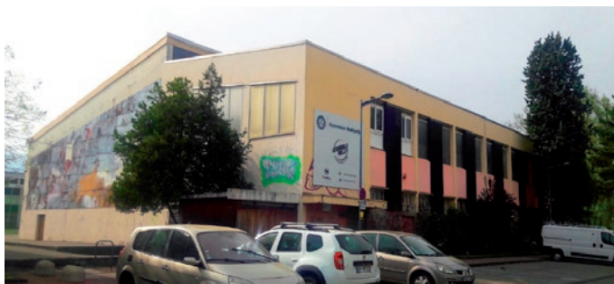
Le gymnase Malherbe avant travaux (façade extérieure).
