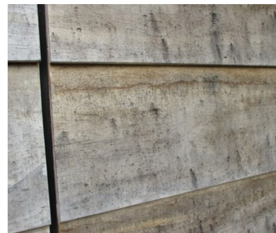
Raue gesägte Oberflächen sind der Aufbauschicht zuträglich
