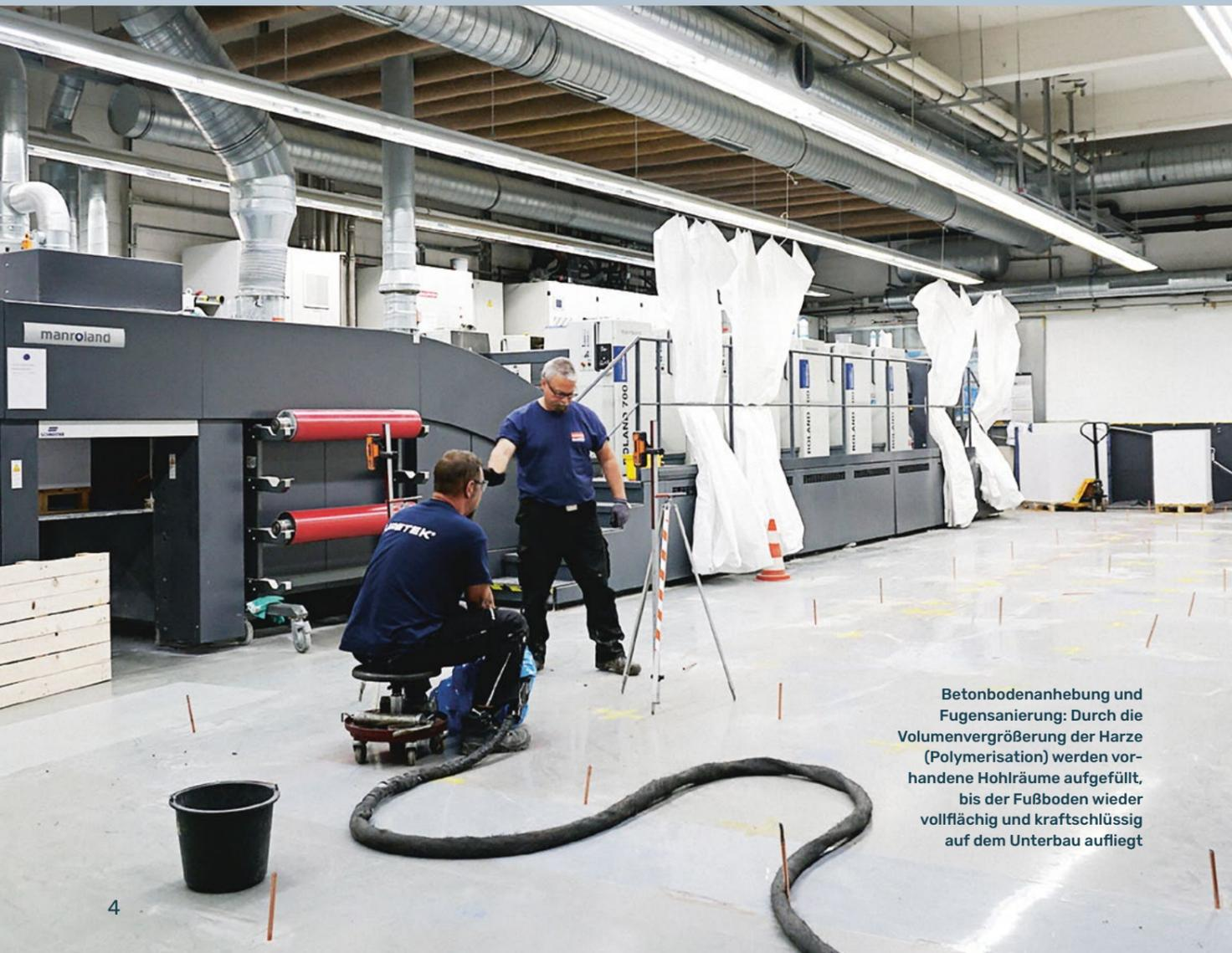
Betonbodenanhebung und Fugensanierung: Durch die Volumenvergrößerung der Harze (Polymerisation) werden vorhandene Hohlräume aufgefüllt, bis der Fußboden wieder vollflächig und kraftschlüssig auf dem Unterbau aufliegt
