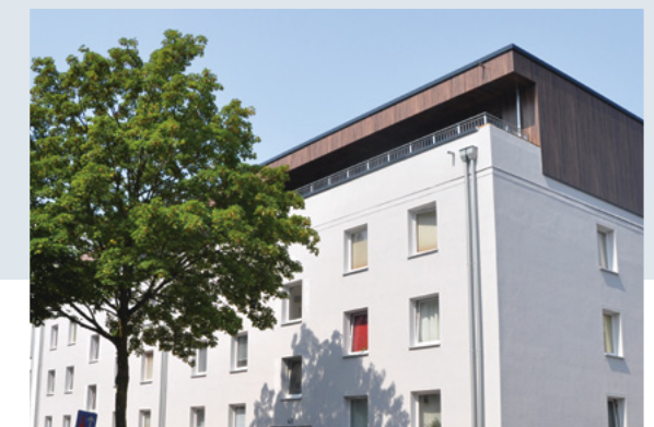
Ausbau von Dachgeschossen mit Lasterhöhungen.
