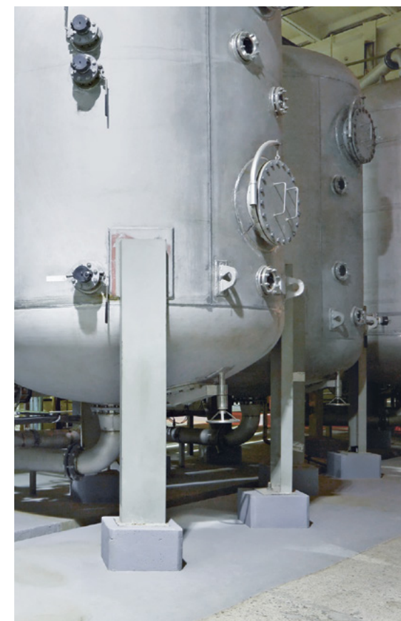
Aufstellen von Behältern, Maschinen und Anlagen auf bestehende Bodenplatten.
