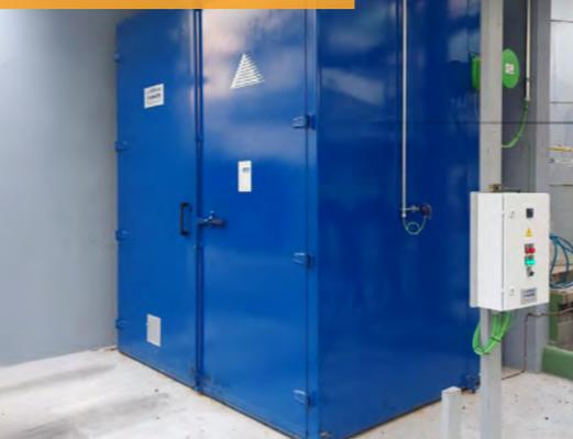
Der Herstellungsprozess für wässrige Polyurethan-Dispersionen erfordert eine Vorwärmung des Rohmaterials, bevor es in den Reaktor gegeben wird. Die Warmkammer, die Dampf zum Heizen erzeugt, wird nun nicht mehr mit Gas sondern stattdessen elektrisch betrieben. Die elektrische Warmkammer hat eine Heizleistung von bis zu 150 °C bei Heizwiderständen von 18 kW.
