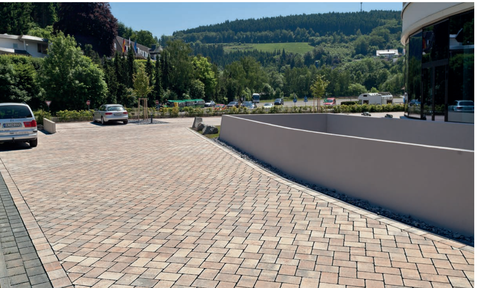
Fischgrätverband, geeignet bis Belastungsklasse Bk3,2
