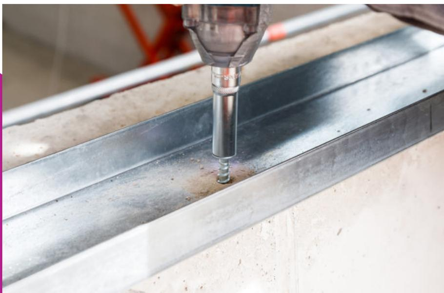
Anschließend wurden C-Profile senkrecht exakt mit einem der Windbelastung entsprechenden Abstand von 625/417 mm montiert. Mit zwei Schrauben wurden die senkrechten C-Profile im U-Profil fixiert (hierbei handelt es sich um hochwertige edificio-Stahlleichtbauprofile der Firma Protektorwerk). Am oberen Anschluss wurde ein Mehrschichtholzbalken angebracht.
