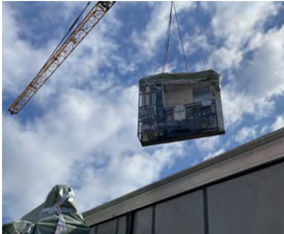
Höhere Planungssicherheit durch Vorfertigung: Unsere Module können just-in-time zur Baustelle geliefert werden. Bildquelle: Expocover
