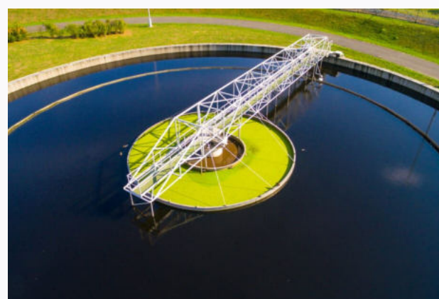
Traitement de l'eau
